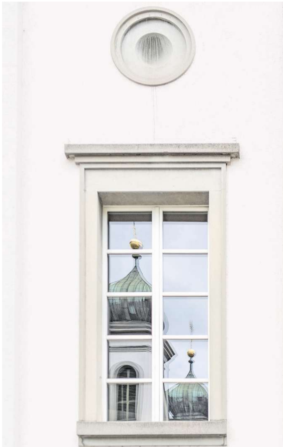
Wie nah werden sich Theater und Jesuitenkirche künftig sein? Dies ist eine der grossen, zu klärenden Fragen.
